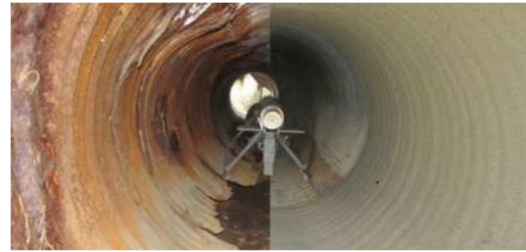
Figuur 13 Oud riool tegenover gerelined riool (Weijzen, 2013)
