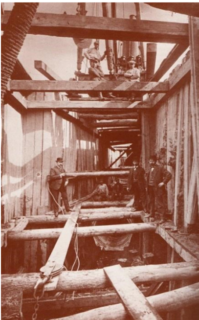
Links: Als helden posteren de heren bij de aanleg van een groot riool. En terecht!
